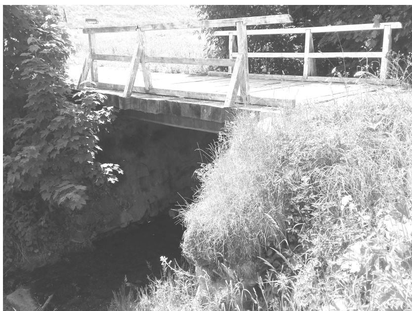
Fot. 2 Widok mostu od dolnej wody.
