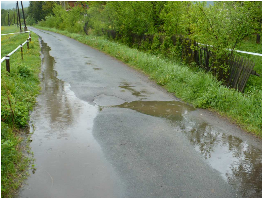
fot. 2 – zapadliska nad zniszczonym przepustem oraz koleina na jezdni
